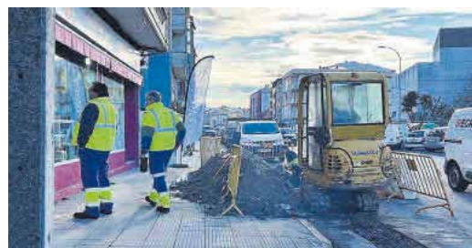
Los hundimientos en ese tramo son frecuentes. | G.Núñez
