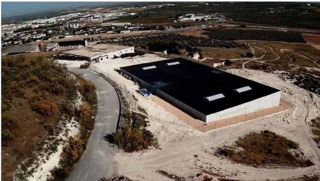
Panorámica del depósito de agua de Puente Genil. / Cabezas
