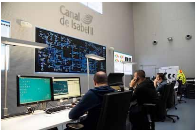
Centro de control del Canal de Isabel II. M. Angel Gomez Canal de Isabel II
